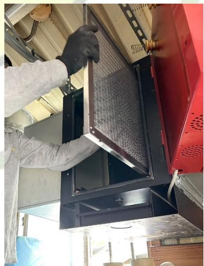
備註：圖片為靜電機打開示意圖（非清洗步驟）。
